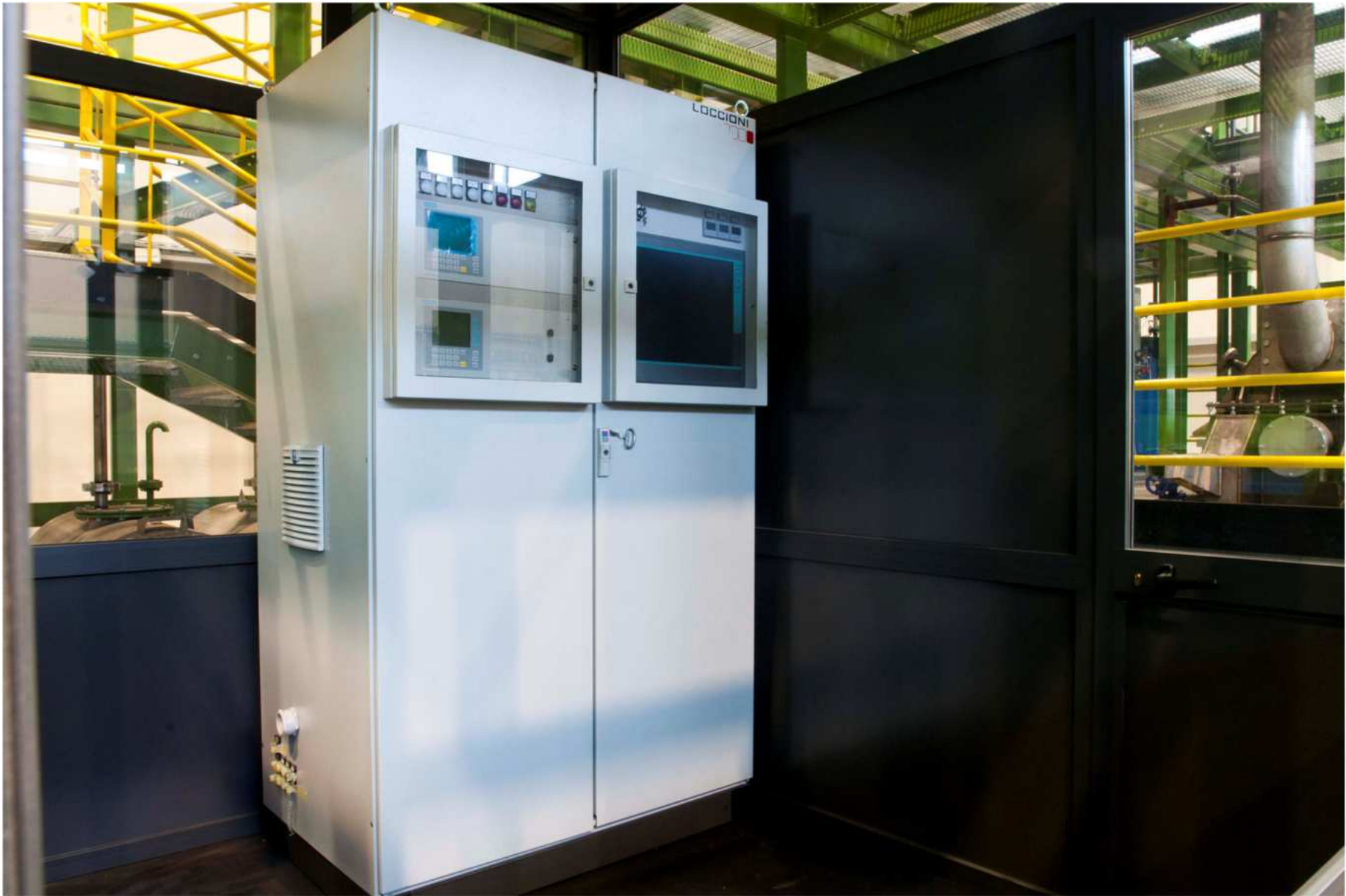
STAZIONE DI ANALISI FUMI (NO x -CO-SO 2 -HCK-O 2 -TOC-POLVERI-PORTATA-TEMP.-PRES.
