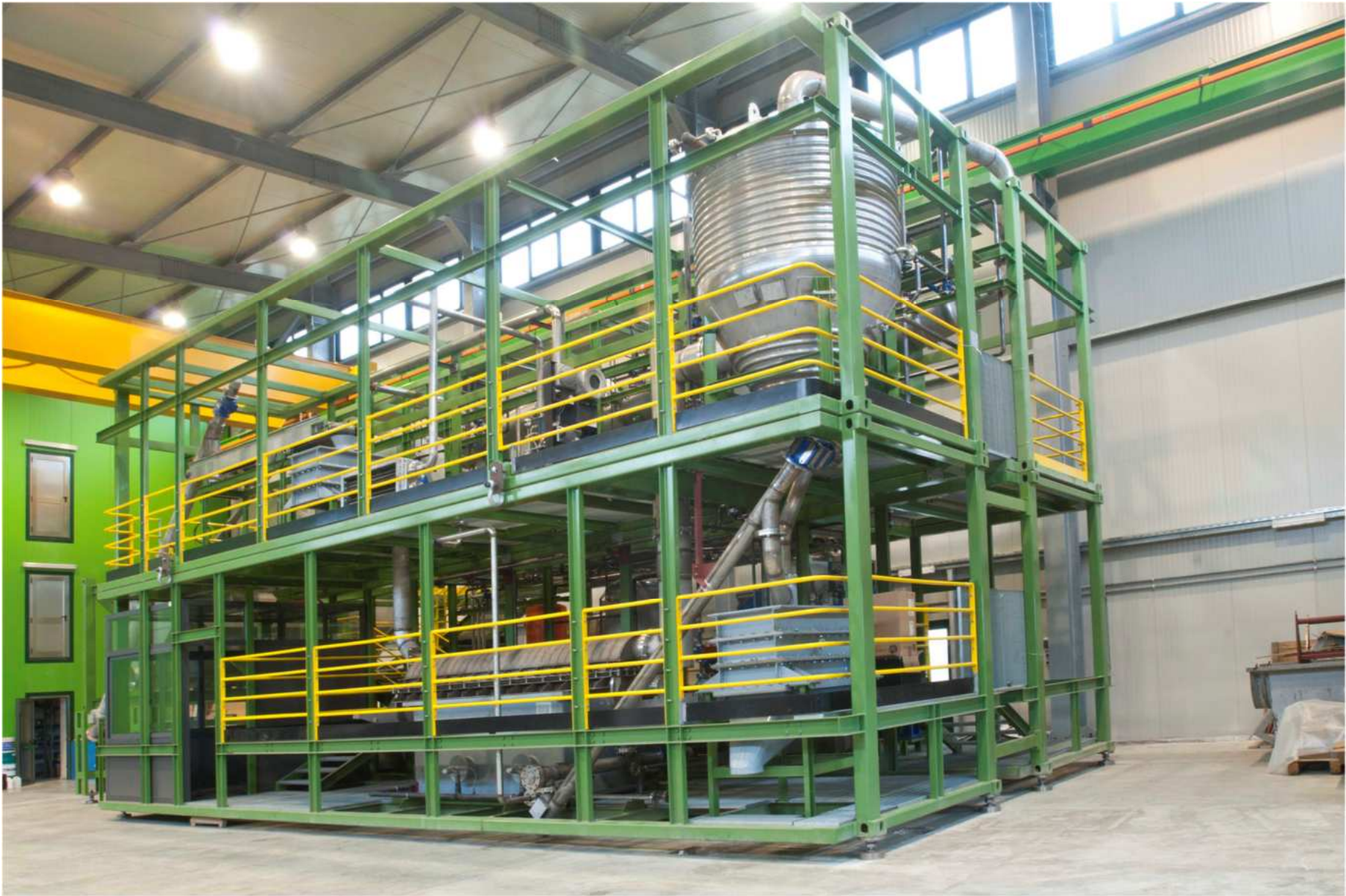
SCARICO CARBONE DAL PIROLIZZATORE – SECONDO ISOLATORE
