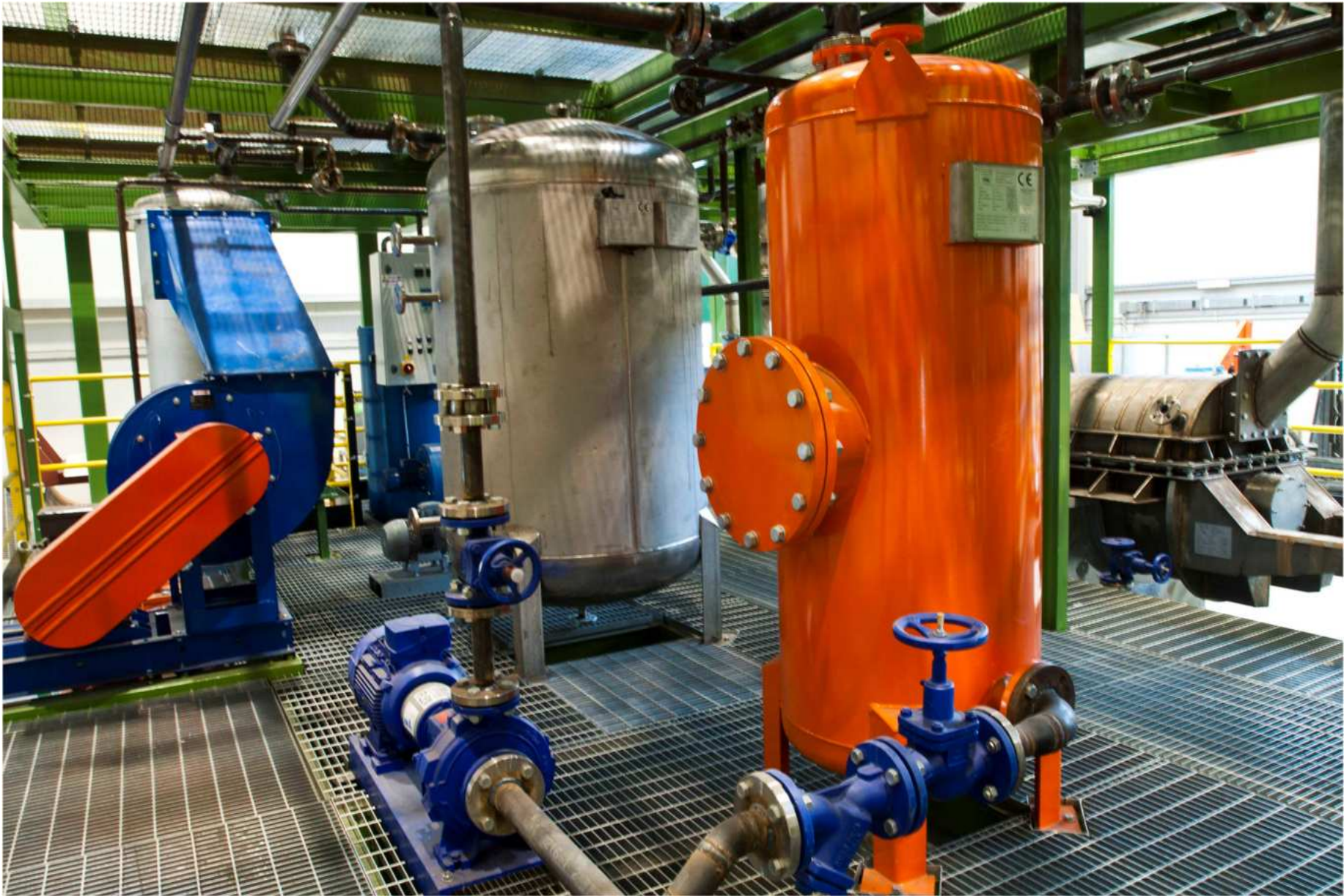
PIANO SERVIZI-CALDAIA OLIO DIATERMICO- SERBATOIO ESPANSIONE
